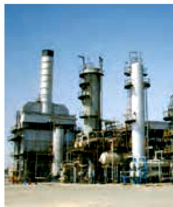
(ب) نمای بیرونی برج تقطیر در پالایشگاه
